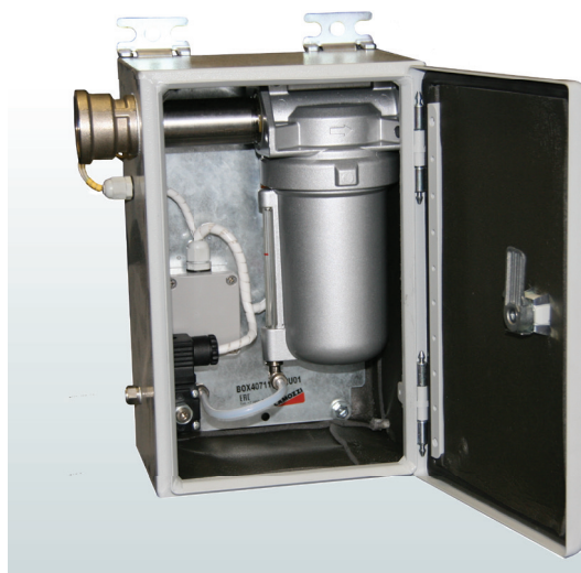
Компактный низкотемпературный шкаф подготовки воздуха Ж/Д
